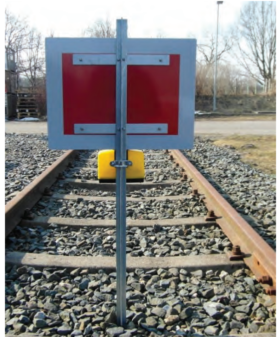
Signal Sh 2, mit Rammständer, Rückseite bei Verwendung eines doppelseitigen Sh 2-Signals
